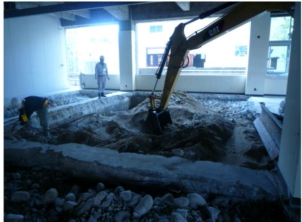
1階室内の床下を掘削(床下に免震ピットを造る):工程③
